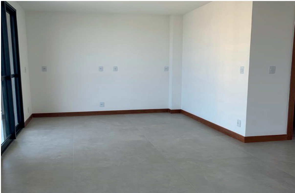
Figura 8 Vedação vertical interna
