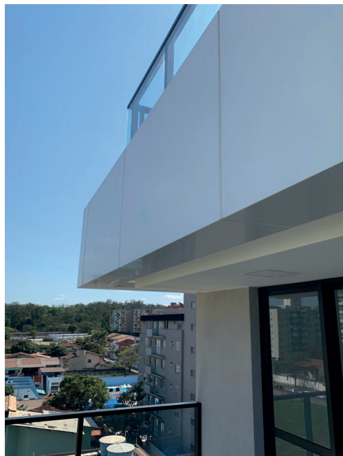
Figura 24 ACM na fachada
