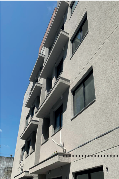
Figura 81 Localização das áreas técnicas da unidade externa de ar condicionado
