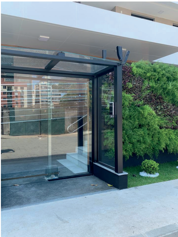
Figura 41 Acesso social com porta de vidro e muro com placas de vidro
