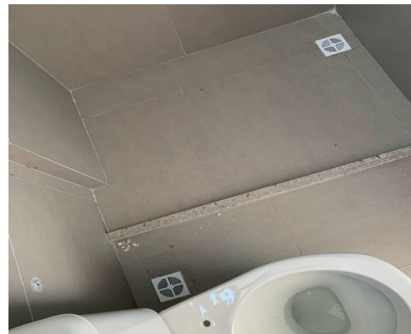
Figura 70 Ralo no banheiro do apartamento
