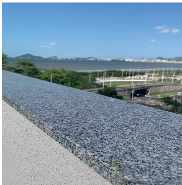
Figura 15 Peitoril de granito na platibanda do edifício
