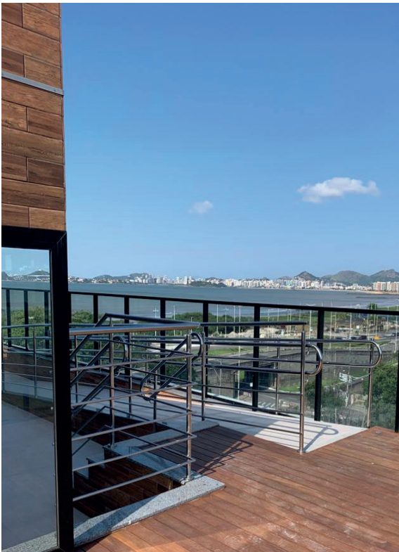
Figura 42 Guarda corpo da área de lazer e esquadrias em alumínio e vidro
