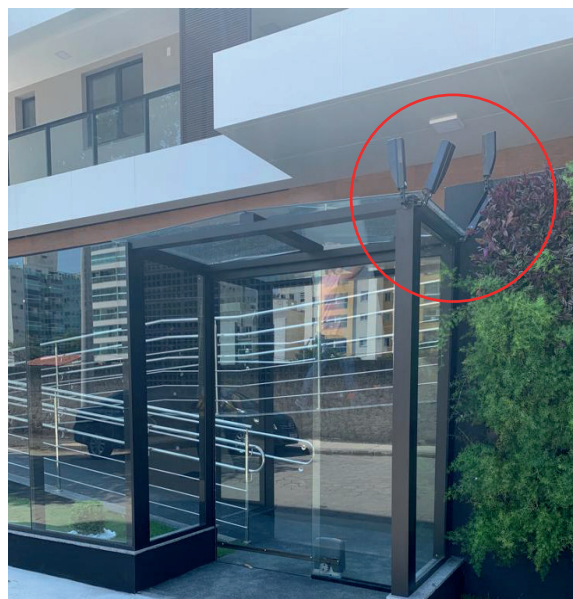
Figura 93 Sensor de barreira
