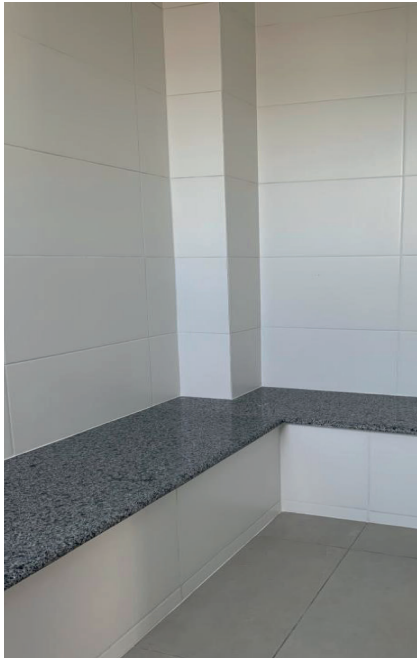
Figura 110 Sauna no pavimento lazer
