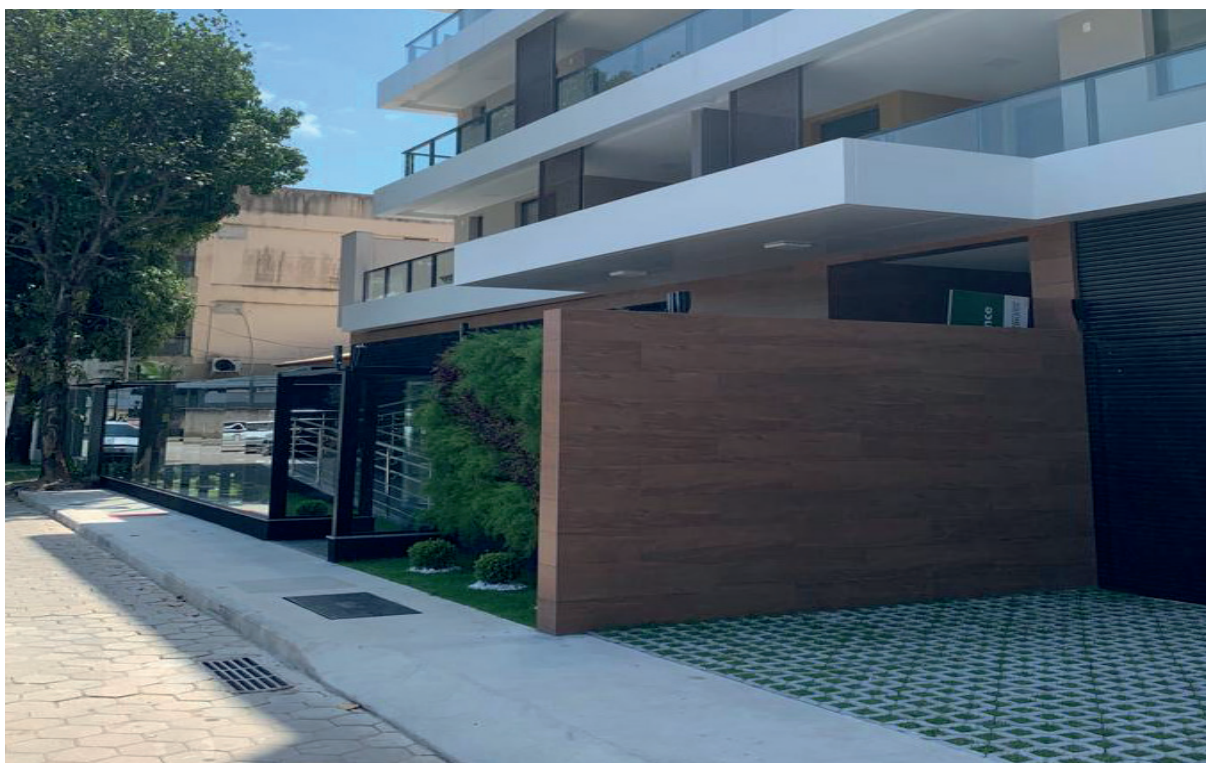
Figura 116 Calçada frontal ao edifício
