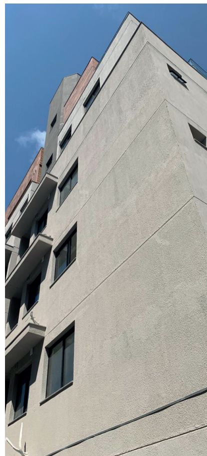
Figura 5 Vedação vertical externa
