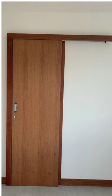
Figura 29 Porta de madeira de correr no banheiro da suíte da unidade privativa
