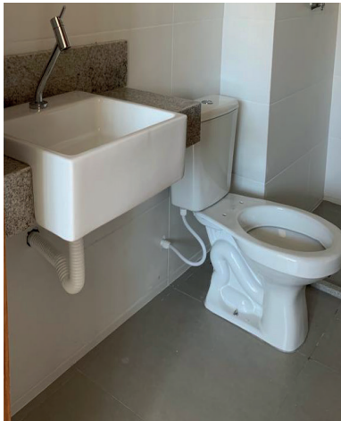
Figura 67 Bacia sanitária conectada com uma ligação flexível
