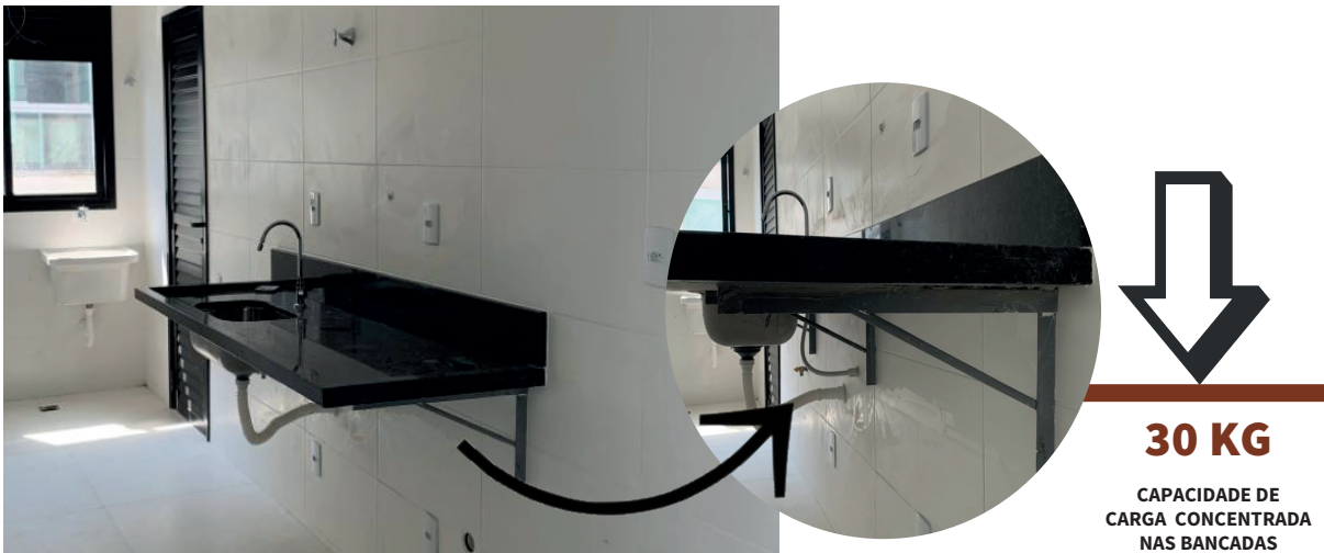
Figura 17 Bancada de granito e detalhe da sua fixação
