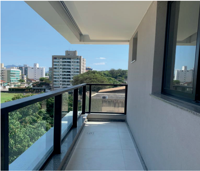
Figura 44 Rebaixamento de gesso na varanda do apartamento
