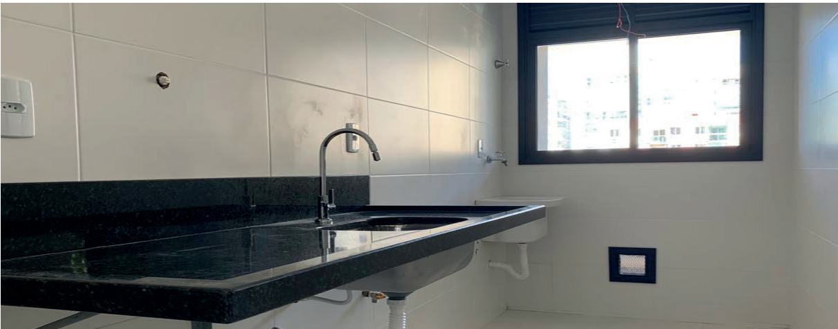
Figura 68 Bancada de granito com cuba de aço inox na cozinha do apartamento
