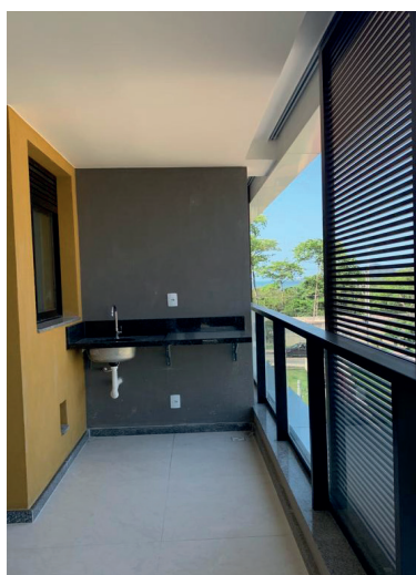
Figura 35 Janela, guarda corpo e veneziana em alumínio na unidade privativa
