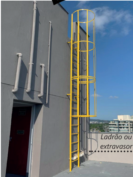
Figura 48 Escada de acesso a caixa d'água superior e detalhe das visitas de acesso
