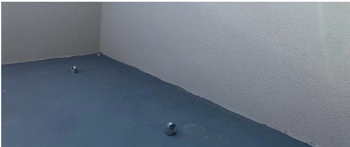
Figura 46 Gancho de ancoragem no piso da cobertura
