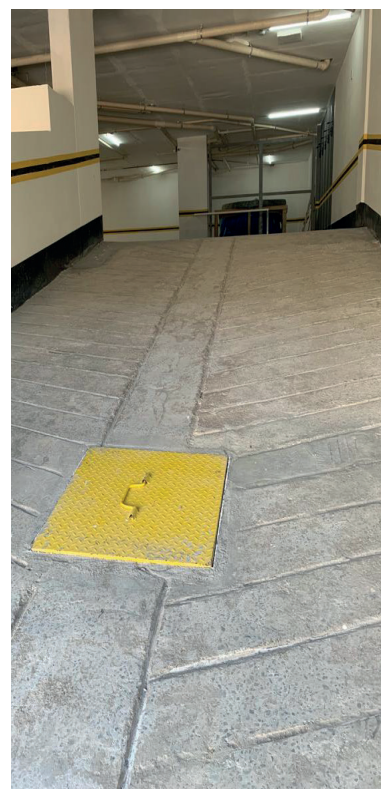
Figura 59 Reservatório de água pluvial está localizado na rampa de veículos
